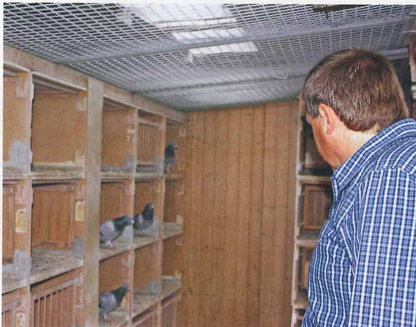
Georg Fröhlingdorf auf Kontrollgang im Reiseschlag. An der Decke sind die Gitter gut zu erkennen, die einen guten Luftabzug nach oben ermöglichen.
