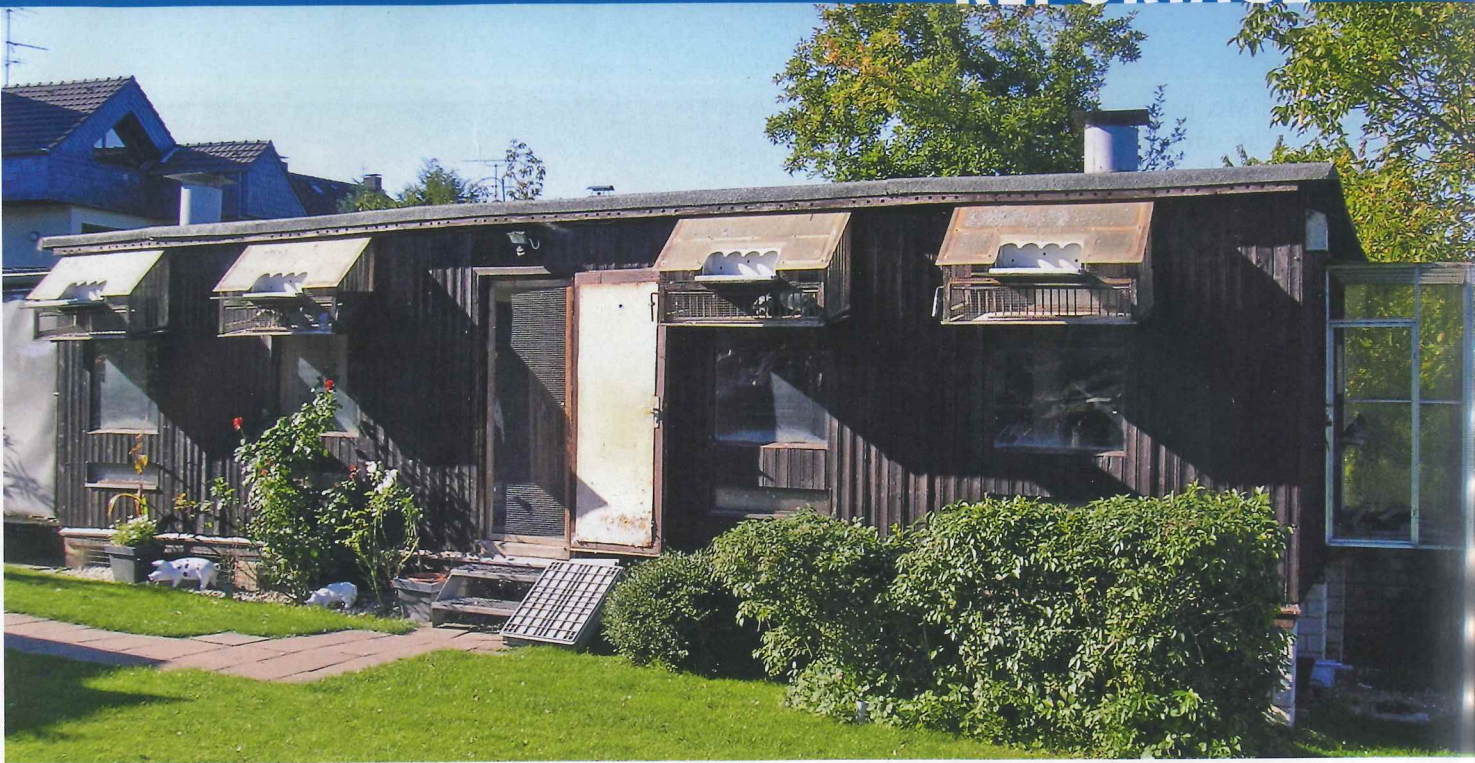
Die Schlaganlage des Verbandsmeisters 2015. Der Holzschlag ist nach Süden ausgerichtet und steht auf gemauerten Pfeilern.
